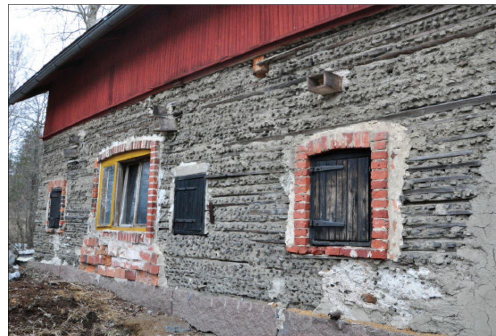
Tallirakennuksen seinät on 1900-luvun alkupuolella rakennettu puurimoista ja savesta, johon on sekoitettu muun muassa sahanpurua.
