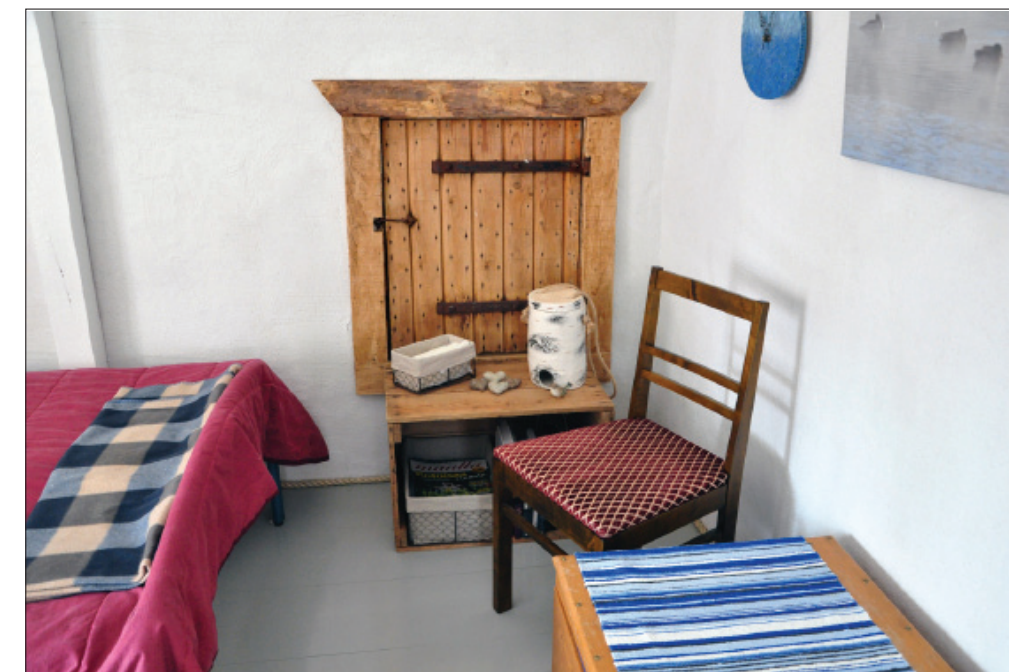
Lantaluukun ympärille tehtiin listoituus antiikkivahalla käsitellystä laudasta. Kun rakennuksen taakse tehdään terassi, voivat ulkona olevat tilat tarjota luukusta kelloa soittamalla.
